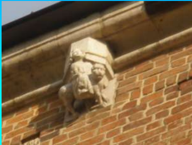
Wsporniki pod gzymsem dachu
