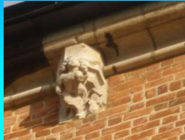
Wsporniki pod gzymsem dachu
